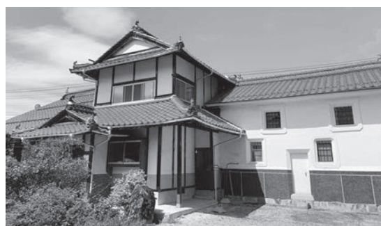
広島県安芸高田市の住居兼オフィス兼加工所。 木造納屋を加工所へと改築し、乾燥機を設置
