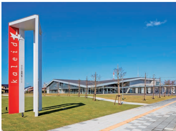
⑥ 石川県野々市市 (p16-17) 学びの杜のいち カレード外観
