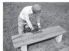
生きがい就業によるベンチ修繕作業
