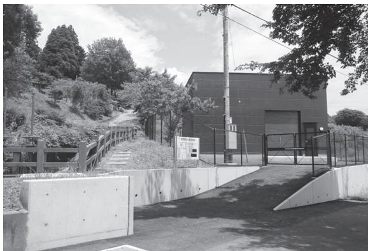
美野原小水力発電所。 美野原用水の幹線水路の高低差 64.48 m を利用した小水力発電施設
