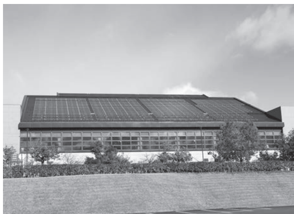
オンサイト PPA により太陽光発電設備を設置した 三段池総合体育館
