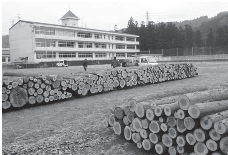
整備が始まった木材活用センター（旧沢田小学校）
