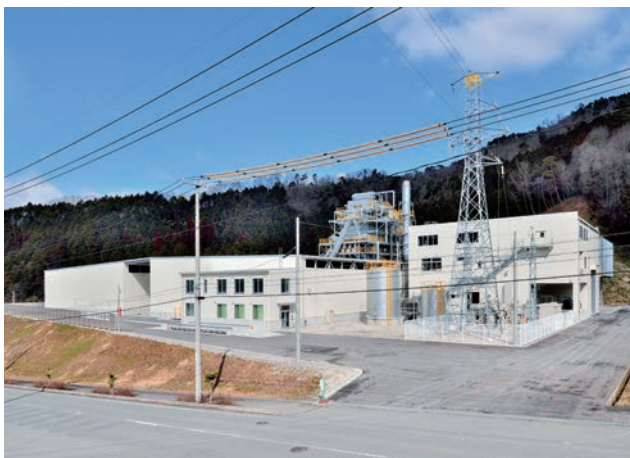
⑩ 岡山県真庭市 (p24-25) 2015年より稼働の真庭バイオマス発電所
