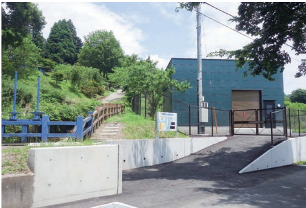
④ 群馬県中之条町 (p12-13) 美野原小水力発電所。美野原用水の幹線水路の高低差64.48mを利用した小水力発電施設
