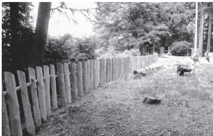
整備後の「浦城」本丸の柵
