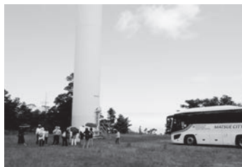
バスによるインフラツアー。江津高野山風力発電所で風車を見上げる見学者
