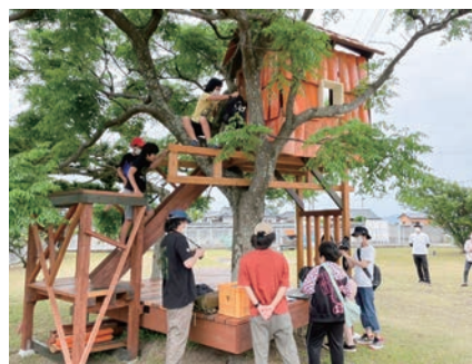
完成したツリーハウス
