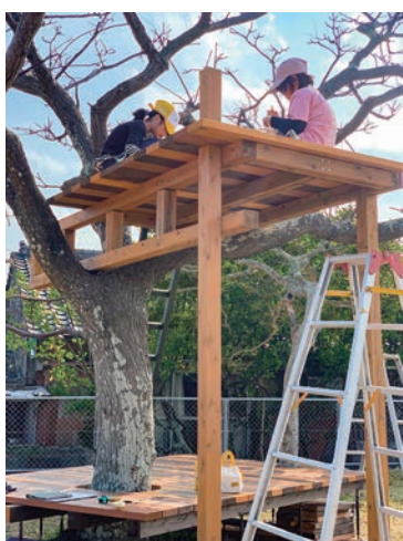
制作中のツリーハウスの上で作業をする小学生
