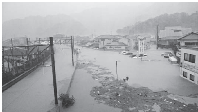
台風による津久見駅周辺（市中心部）の浸水状況
