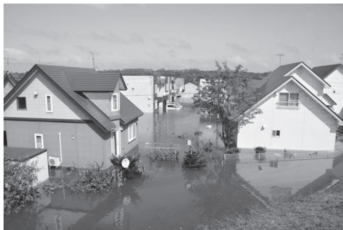
平成28年台風10号被害により浸水した市街地
