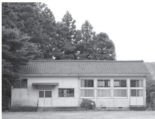
改修前の旧吉田小学校春日分校
