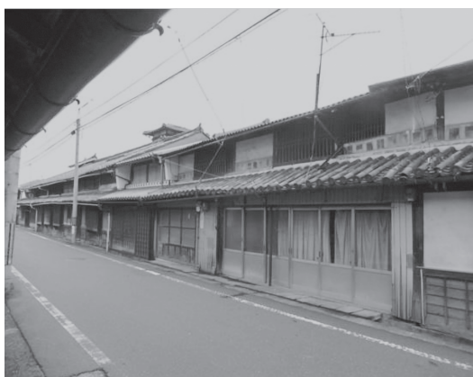
「城下小宿 糺や」に改修する前の町屋
