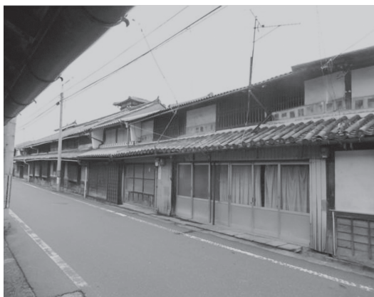
「城下小宿 糺や」に改修する前の町屋
