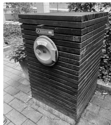
ハンマビー・ショスタッド地区内にあるゴミシューター
