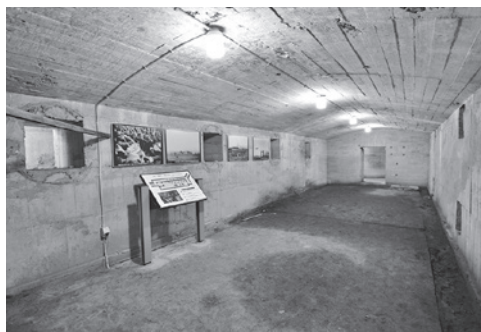
串良地下壕(鹿屋市)
