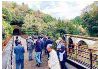
視察幻の広浜鉄道今福線第一下府川橋梁
