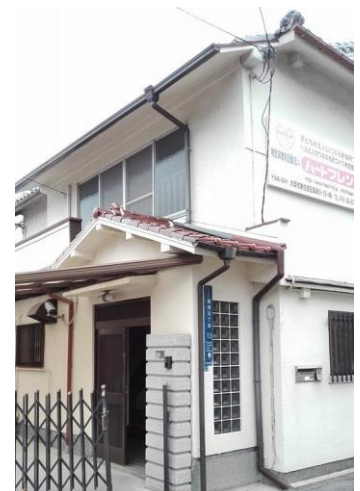
▲ハートフレンドの外観
