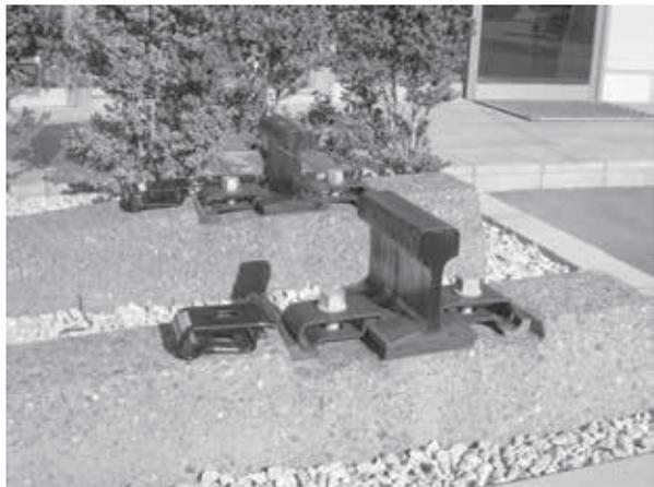
レールを枕木に固定する締結装置に使用される「板ばね」(レールをボルトで固定している部品)。左側はボルトを外した状態の板ばね
