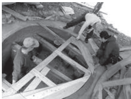
新たな炭焼き窯の構築作業
