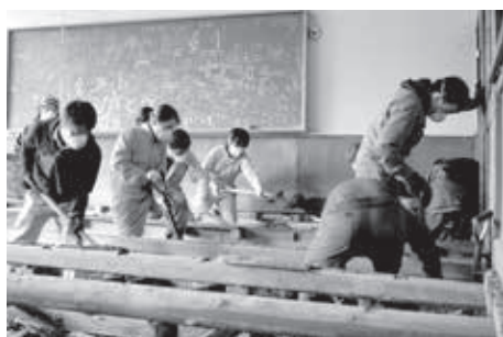
廃校の改修作業。地域住民や廃校の卒業生、モリウミアスのプロジェクトに関わる全国各地の応援者が集まり、平成25年4月から手作業で廃校改修作業を始めた。年間2500人が改修イベントに参加している
