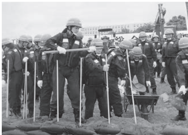
荒川河川敷での水防訓練で、土嚢積み作業
