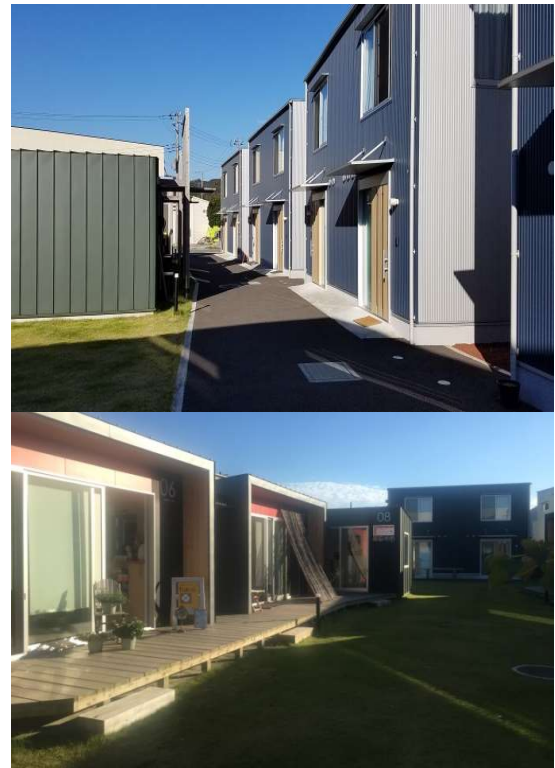
写真 2,3：ドットツリー住宅区（上）と ビジネス区（下）
