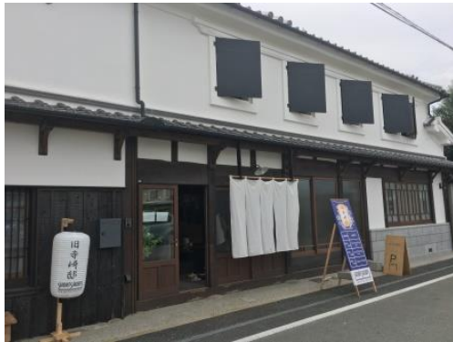
旧寺崎邸の外観
