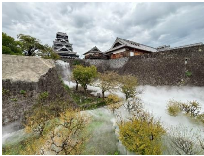
改修中の熊本城
