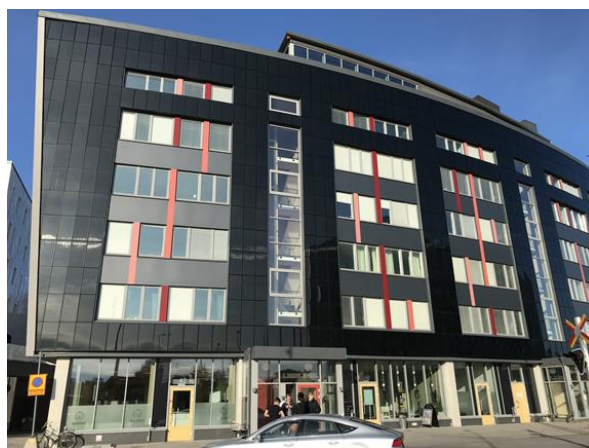
壁面に太陽光パネルを設置した建物（ウプサラ市内）
