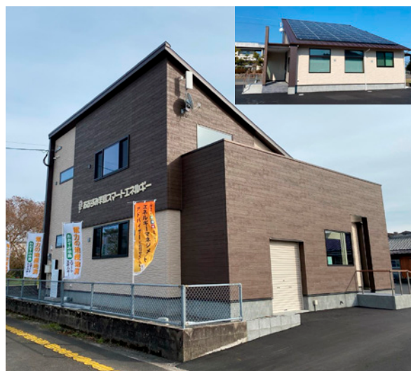
ZEB（ネット・ゼロ・エネルギー・ビル）仕様の自社事務所
