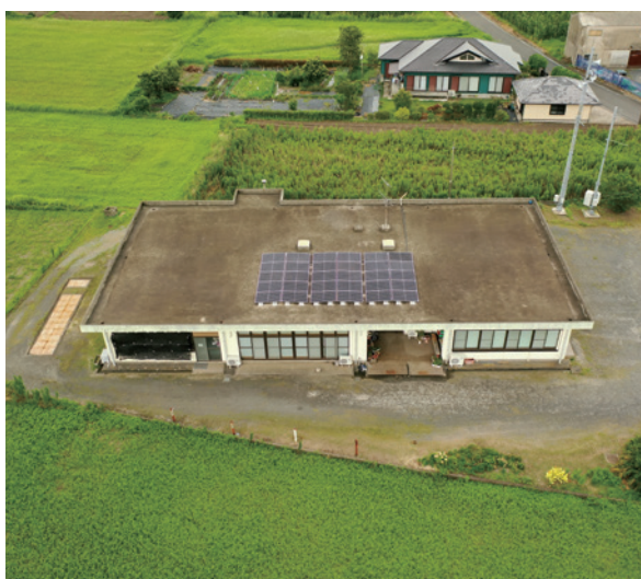
肝付町へ寄贈した太陽光発電設備
