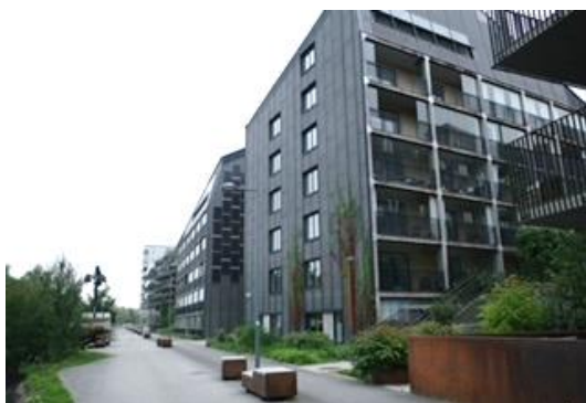
図15 プラスエネルギーハウス（筆者撮影）
