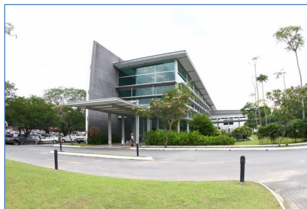
ロイヤルセラランゴール・ビジターセンター外観
