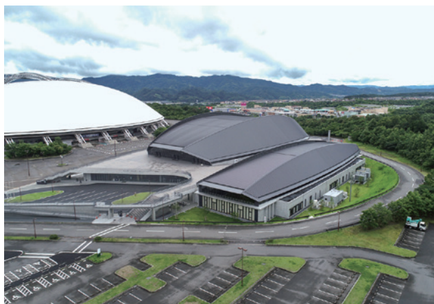
大分県立武道スポーツセンター全景
