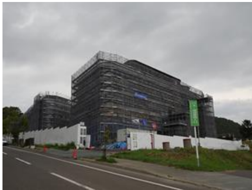
建設中のコンドミニアム
