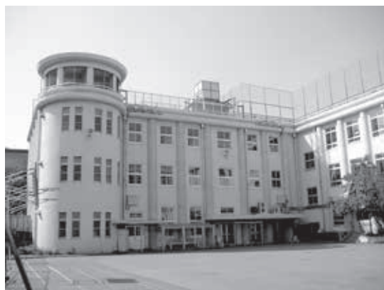
台東デザイナーズビレッジ外観。昭和3年に建てられた関東大震災の震災復興小学校。ギリシャ風の円形の望楼が印象的だ
