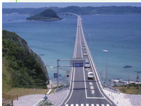
本州と角島（奥）を結ぶ角島大橋
