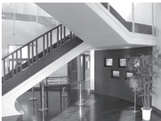
正面エントランスホールの床材と2階への階段は、旧西警察署庁舎で使用していた木材を再利用している
