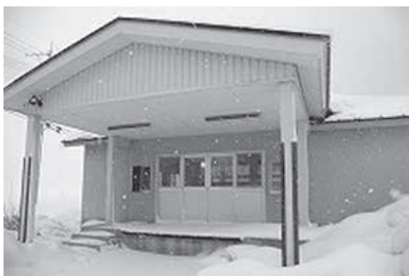
旧三岳小学校（改修前）
