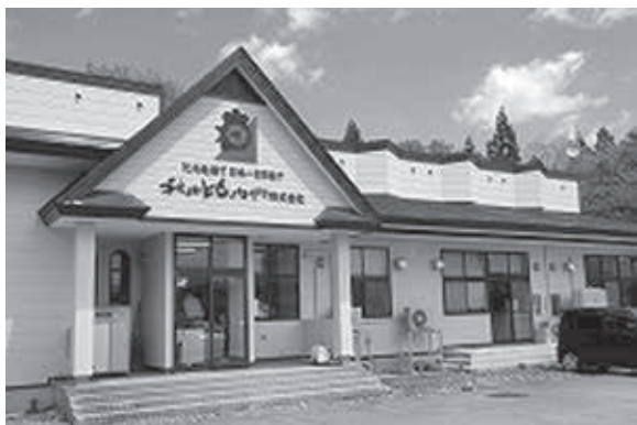
比内地鶏関係の会社の事務所兼食品加工室（改修後）
