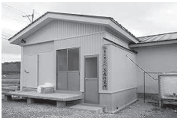
山芋の皮むき作業所の冷蔵庫室（改修後）
