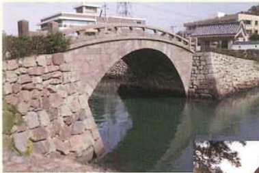
幸橋 (オランダ橋)
