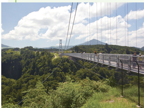
九重〆夢〆大吊橋
