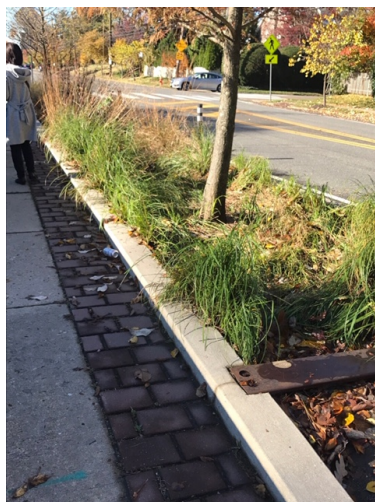
(写真1) Queen Lane Stormwater Bump-outs (図3) Stormwater Bump-outs の位置図 (W. Queen Lane にて筆者撮影) (City of Philadelphia, Water Department 提供資料)
