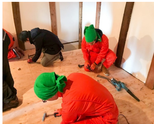
(小川村での空蔵の改修の様子)
