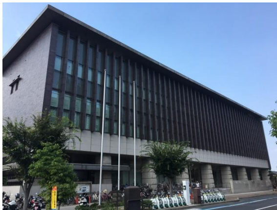
【岡山県立図書館(外観)】
