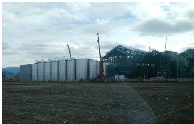
写真 12：建設中の志比田第二増設工場
