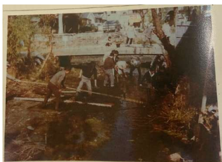
図 13 住民による浚渫作業 しゅんせつ
