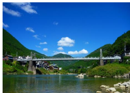
図 1 土木遺産 白川橋
