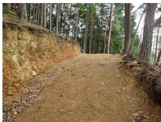
写真5. Aさんが建設した作業道
