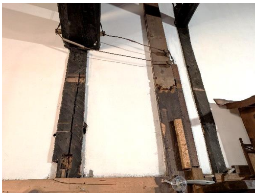
図3 継手と仕口の跡(筆者撮影)
