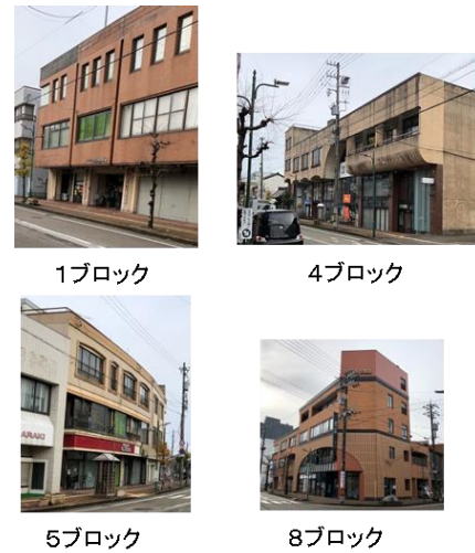
写真 1「第 1 種市街地再開発事業によって整備された建物」
