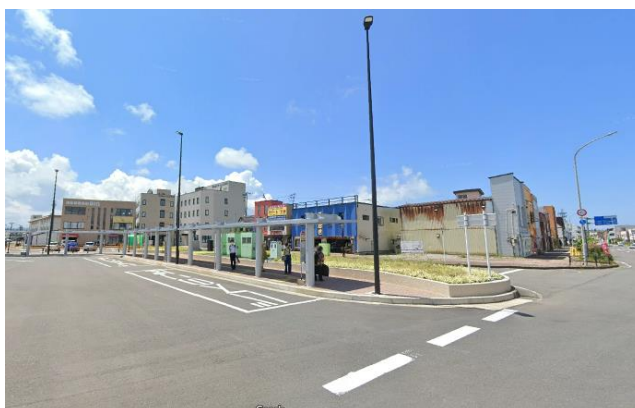
西口駅前広場 通路シェルター (著者撮影)
