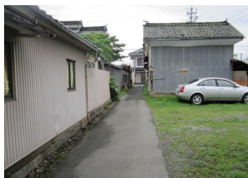
写真 2 トタンで修復された蔵
