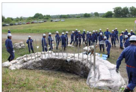
写真1 水防訓練での月の輪工（安八町企画調整課撮影）【平成26年5月25日撮影】
